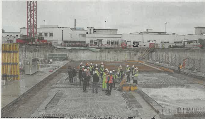
Am Eichenweg 2 entsteht ein neues Büro- und Gewerbegebäude.
